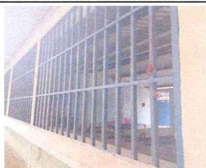
Foto 6: VENTANAS: Mantenimiento a balcones de metal
