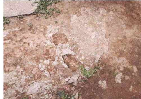
Foto 4: MODULO 2 LOSA DE PATIO: Reparación de planchas de concreto de patio
