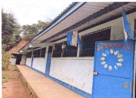
Foto 3: PUERTAS DE METAL: Mantenimiento a estructura (lijado, cambio de tubo , cepillado, sujeciones, aplicación de pintura)
