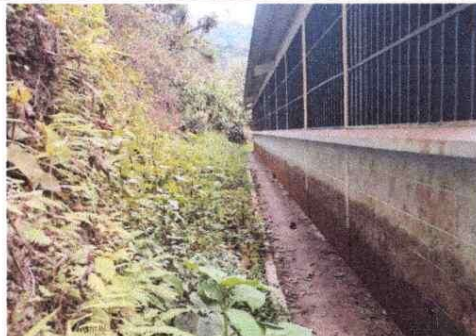
Foto 2: VENTANAS: Mantenimiento a balcones de metal
