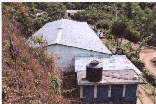
Foto1: MODULO 1 CUBIERTA DE LAMINA: Sustrucción de lámina, por lámina troquelada aluzinc calibre 26
